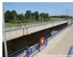
Im Zuge der Anpassung der Mittelweser wurde die Schleuse Dörverden den gestiegenen Anforderungen des Schiffsverkehrs angepasst (2009 - 2013). Der bauliche Zustand der vorhandenen Schleusenanlagen erforderte den Ersatz durch einen Neubau. An der Schleuse befindet sich eine Rastmöglichkeit mit InfoPoint und Aussichtsplattform. [www.wsa-weser.wsv.de](http://www.wsa-weser.wsv.de)
